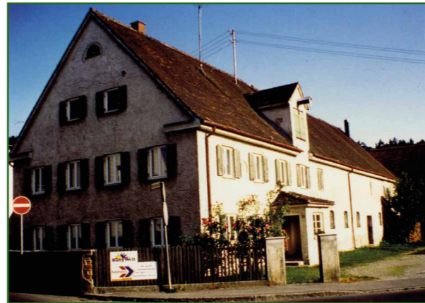
Die Aufnahme zeigt den Bauernhof vor dem Abriss 1995.
